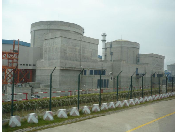
ภาพอาคารคลุมเครื่องปฏิกรณ์นิวเคลียร์
