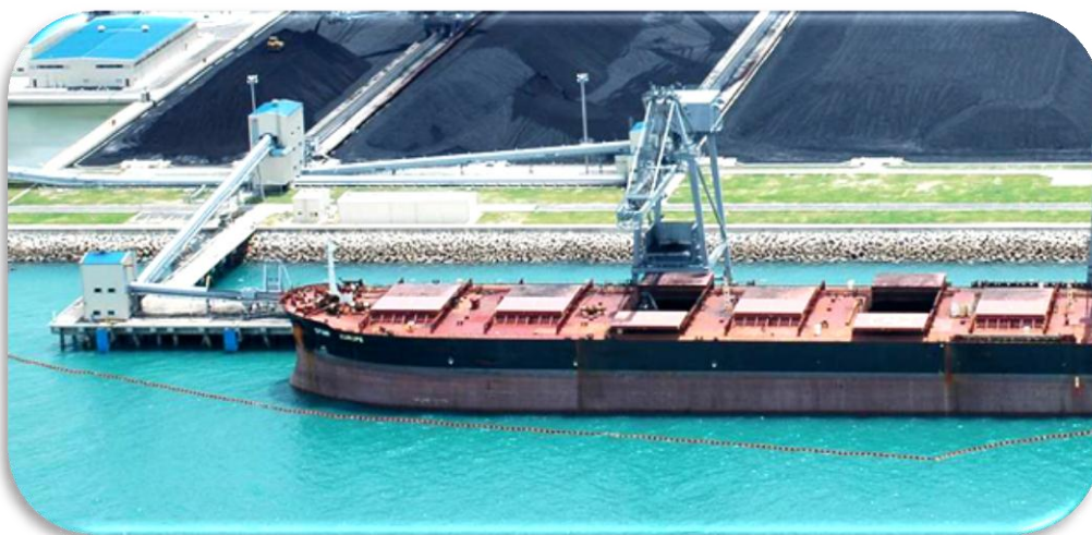
ท่าเรือขนถ่ายถ่านหินอยู่ติดกับตัวโรงไฟฟ้าบีแอลซีพี
