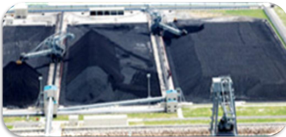
ลานกองถ่านหินในโรงไฟฟ้าบีแอลซีพี
