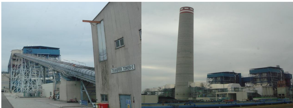
อาคารป้องกันการฟุ้งกระจายของฝุ่นละอองและปล่องระบายความร้อนสูง ๒๐๐ เมตร
